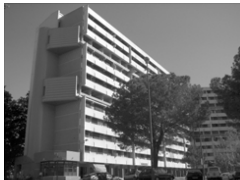
Photo 9 HLM de logements collectifs du quartier Bellefontaine, vers 1971, Toulouse, Architecte : Georges Candilis.
