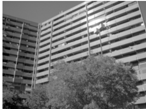
Photo 10 HLM de logements collectifs du quartier Bellefontaine, vers 1971, Toulouse, Architecte Georges Candilis.
