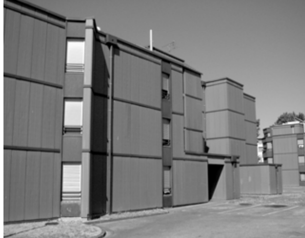
Photo 17 (E) Façade Ouest de l'édifice B du projet les Soulanes On note le système expérimental de revêtement en terra-cotta
