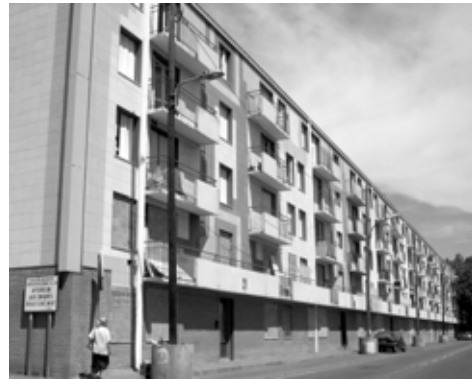
Photo 8 HLM de logements collectifs du quartier de Bagatelle, vers 1950, Toulouse (Les premières "barres" à Toulouse).
