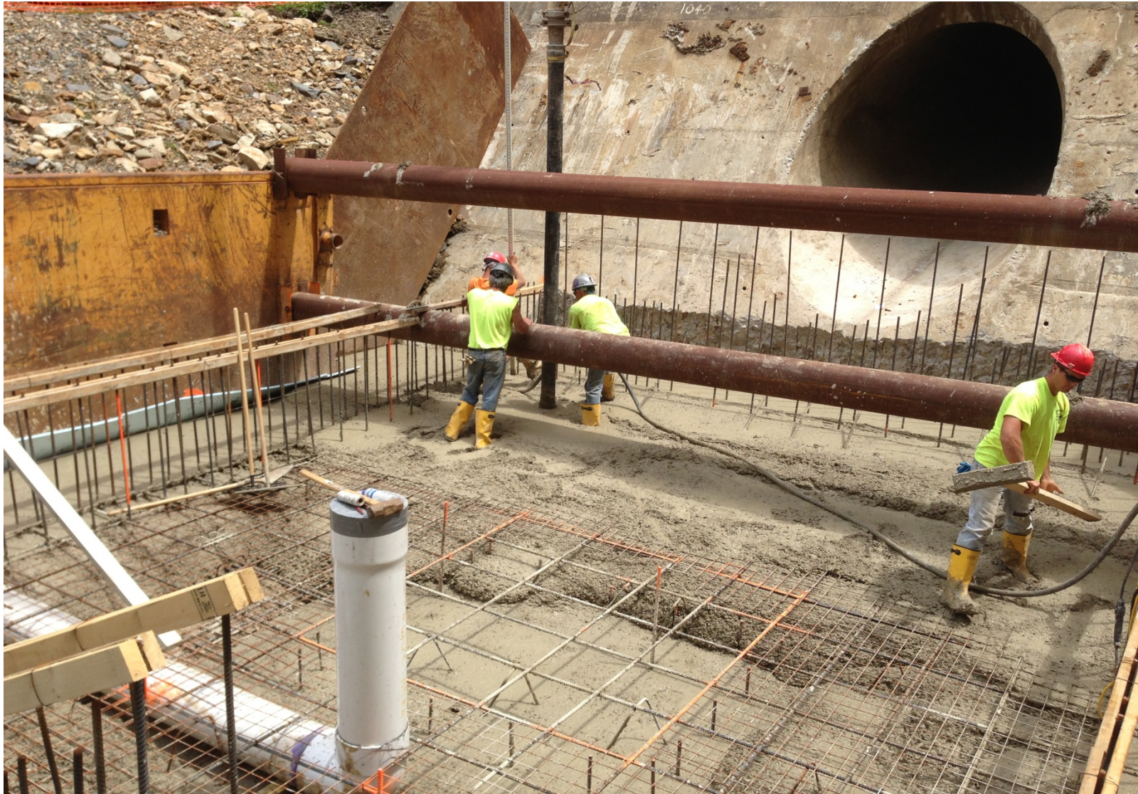
Valve vault base slab pour on 07/31/2013
